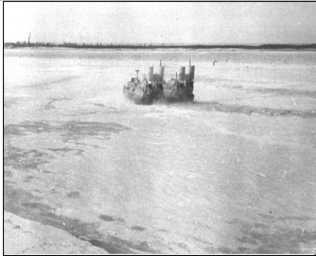
Рис. 2. КВП «Скат» при групповой работе по разрушению льда (движение фронтом)
