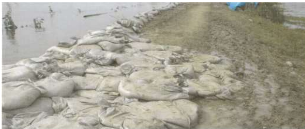
Рис. 8. Укрепление внешнего откоса существующей защитной дамбы мешками с песком, сентябрь 2013 г.
