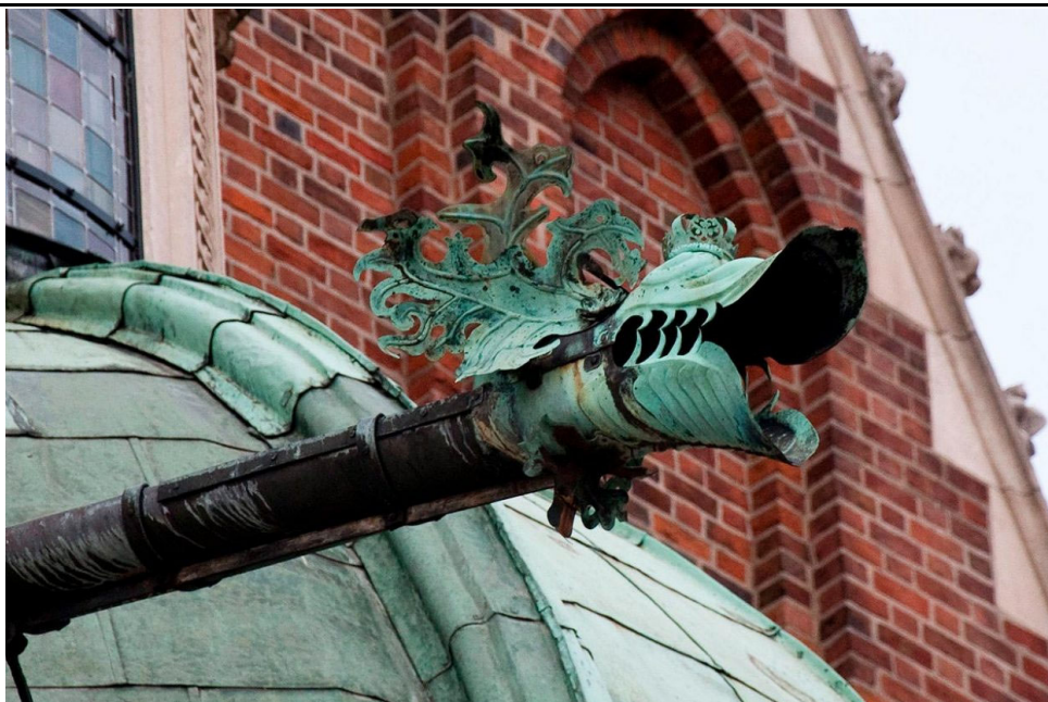
Рис. 3. Гаргулья, выполняющая функцию водоотвода [4]
