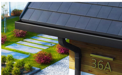
Рис. 4. Примеры применения наружного водоотвода для скатной крыши [11; 12]
