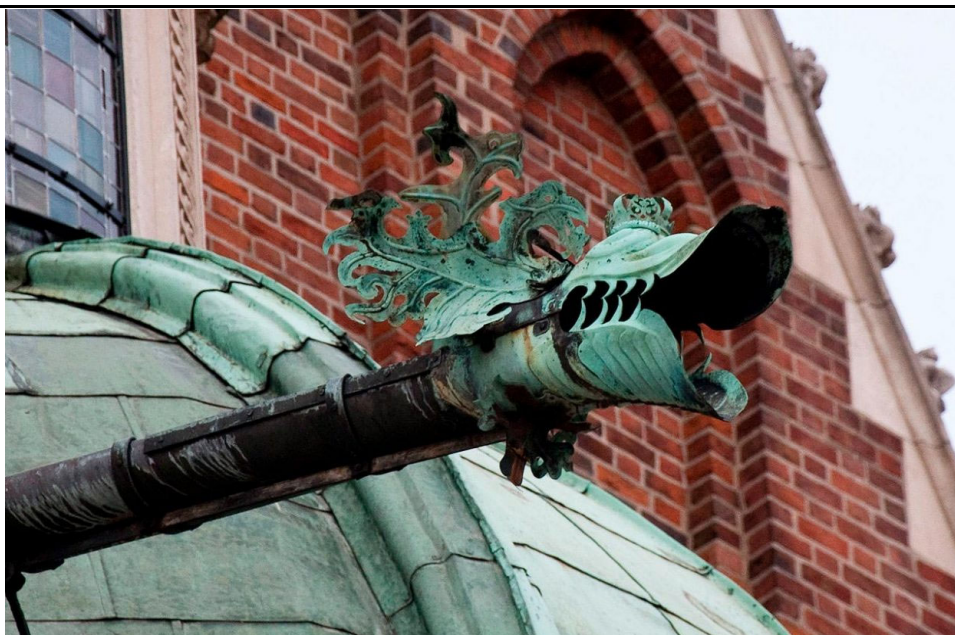
Рис. 3. Гаргулья, выполняющая функцию водоотвода [4]
